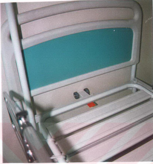
Resim 21: Hasta yatağının duvar ile ilişkisine ait ayrıntı; yatak başı hareketleri sırasında duvarı koruyan tekerlek sistemi
