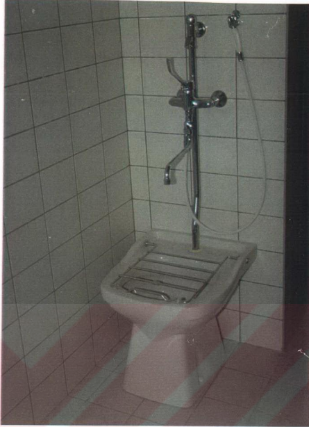
Resim 8: Genel temizlik odasında bulunan temizlik ünitelerinden biri; duş başlığı kirlerin hızla uzaklaştırılmasını sağlar.
