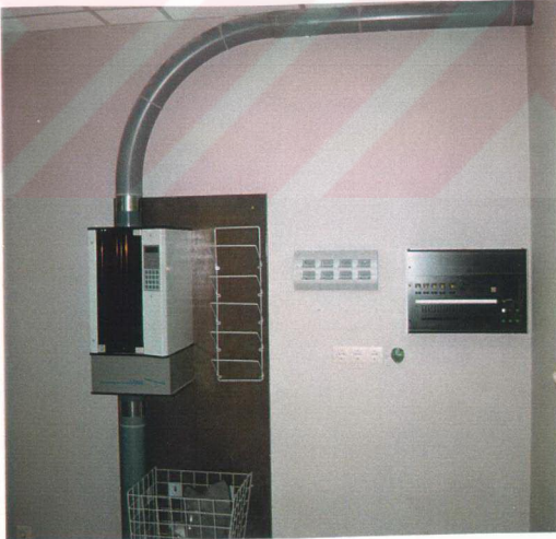
Resim 4: Pnömatik taşıma sistemi; her katta hemşire istasyonunda bulunmaktadır ve 1kg'ı aşmayan malzeme, kağıt, hasta materyelinin katlar arasında taşınmasını sağlar.
