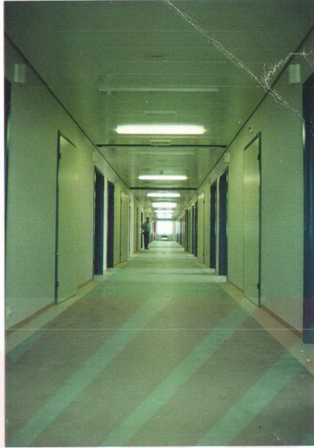
Resim 1: Koridordan genel görünüm; yer döşemesi olarak linoleum kullanılmış, duvarlar olabildiğince boş bırakılmış ve gereksiz girinti çıkıntılarının bulunmamasına dikkat edilmiştir.
