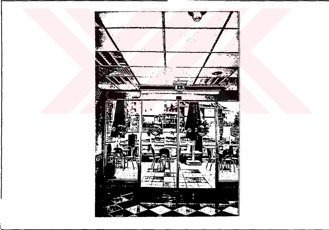
Resim 3.43.: Panel asma tavan sisteminde menfez örneği.
