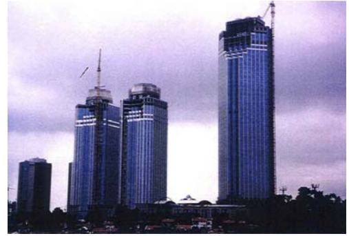
Resim 5: İş bankası,Genel Müdürlük Kompleksi
