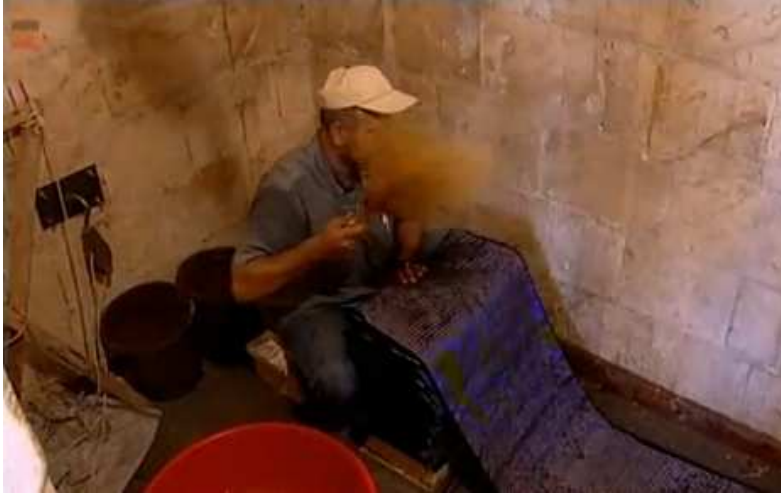
Resim102: Çalı süpürgeyle nişeleme işlemi
