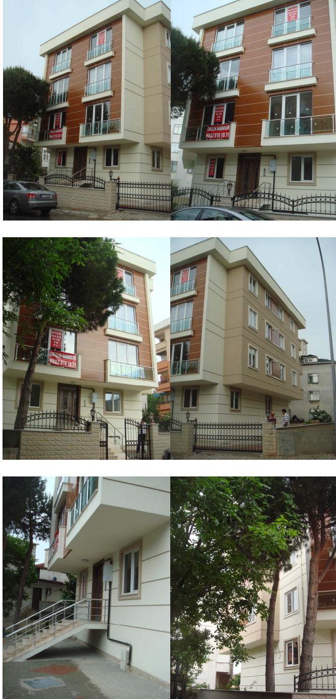
Resim 3. 395-400. Özdemir Apartmanı Dış Mekân Resimleri
