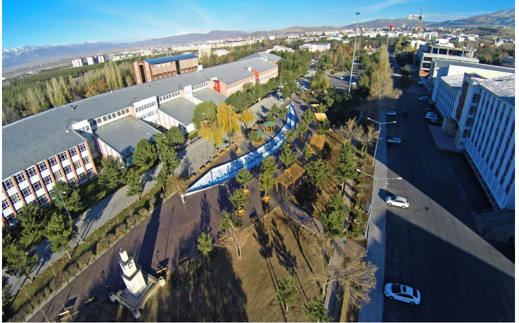
Şekil 4.9. Çalışma alanının tasarım yapıldıktan sonraki mevcut durumu (Kasım 2015)
