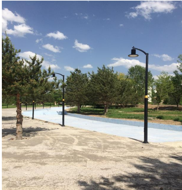
Şekil 4.3. Proje alanının ara değerlendirme yapıldığı dönemdeki mevcut durumu
