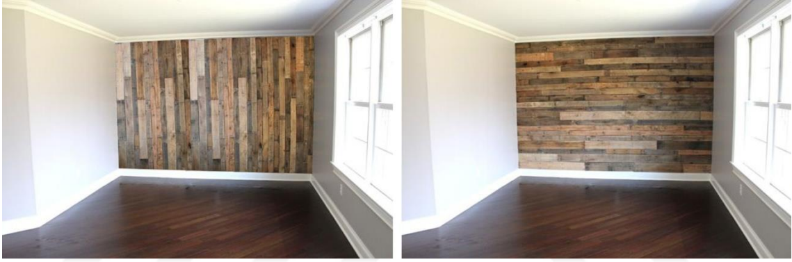
Resim 29. Dik ve Yatay Çizgilerin Mekanın Yüksekliği ve Genişliği üzerinde Etkisi, Çizim: N. Alici
