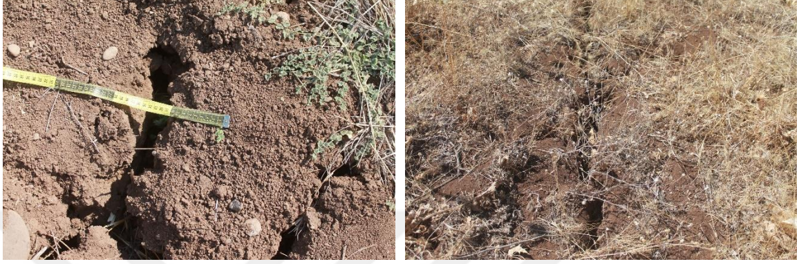
Şekil 4.6. Toprak yüzeyinde kil tipi ve iklimin etkisiyle oluşan çatlaklar
