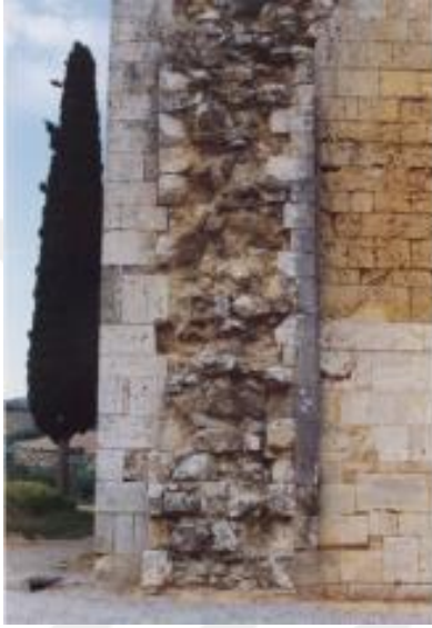
Şekil 3.13. Üç katmanlı kesme taş duvar kesiti (Tomazevic 1999)
