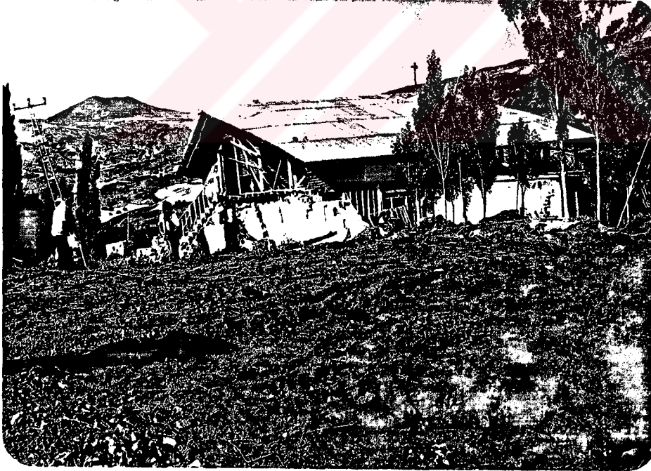
Şekil 4.14. Heyelan sonucu yıkılan ev
