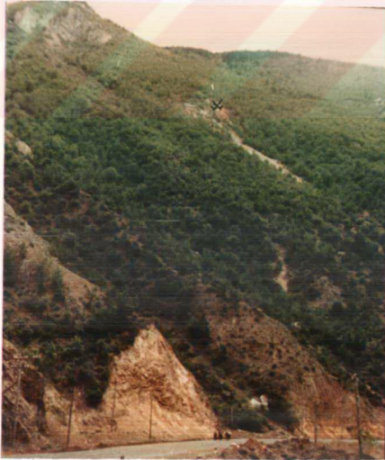
Şekil 5.43 Sinkot zuhurunun genel görünüşü.
