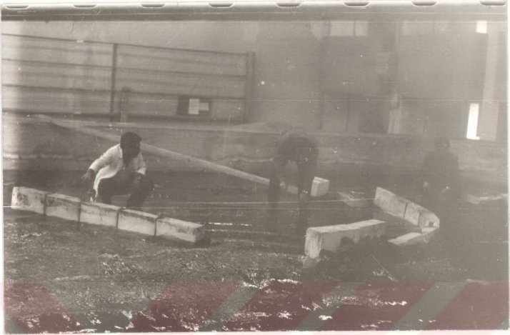
Fotoğraf 5.3 Ytong Taşlarının Dizilmesiyle Mendirek Yapılması
