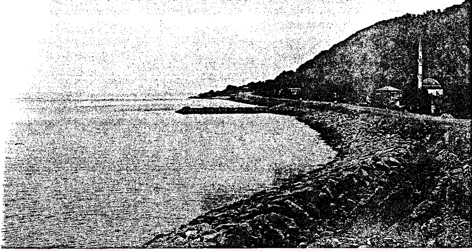
Şekil 5. 34. Kıyıdan Geçirilen Yol Kıyı Tahkimatını Gerek- tirir
