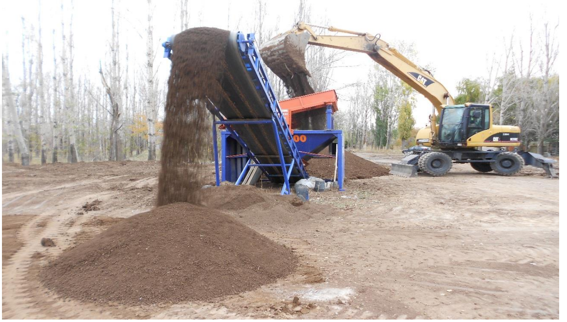
Şekil 3.6. Toprak eleme ünitesiyle toprağın elenmesi
