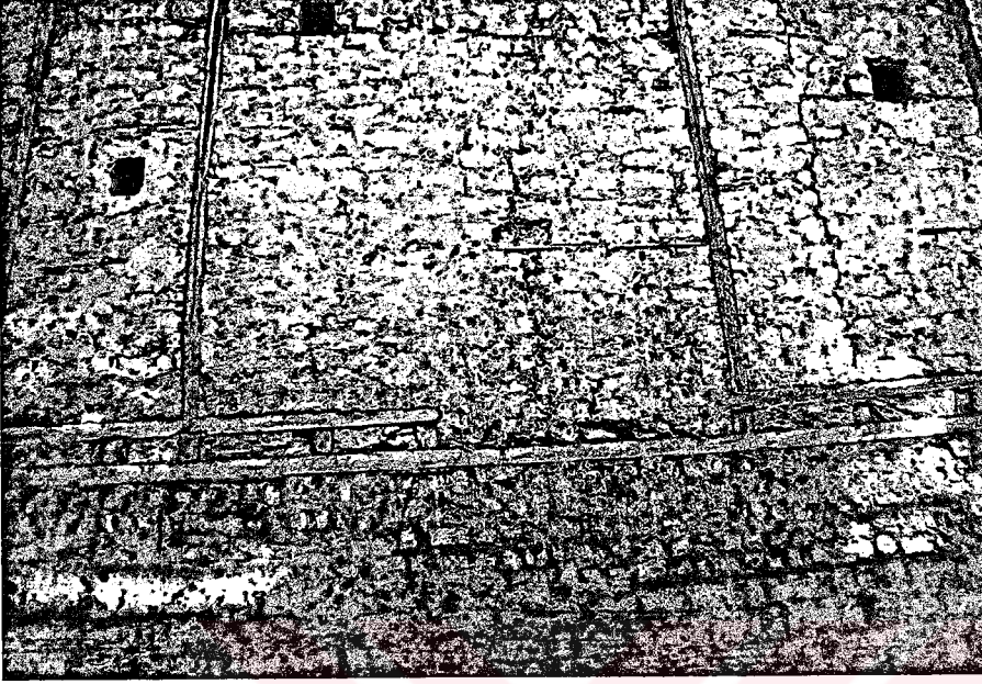
Şekil 16: Kerpiç-Ahşap Kullanımı
