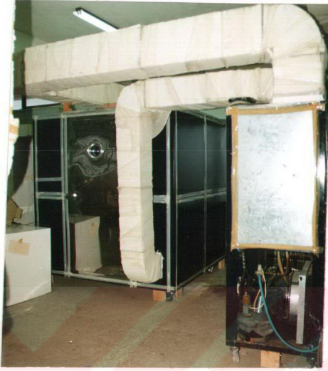
Şekil 10. Şartlandırma odasının klimaya bağlantısı.
