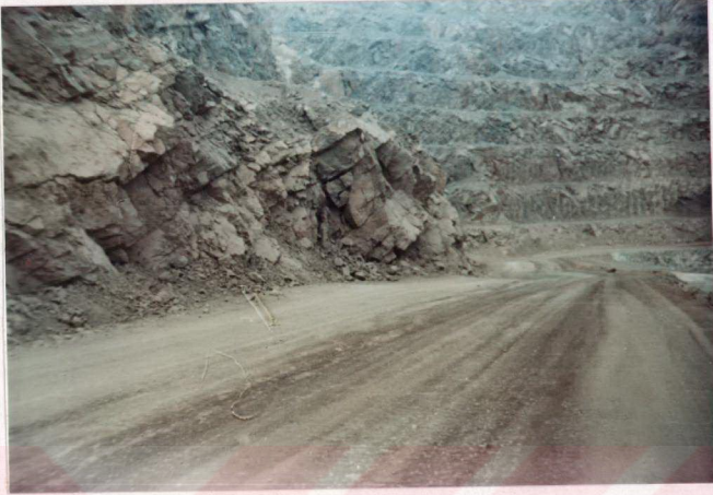
Şekil 6.1. Batı kesiminde gözlenen devrilme türü kayma yapıları
