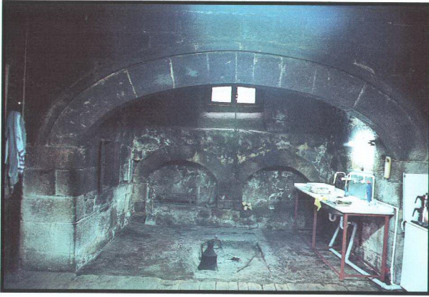
Şekil 23. Çamlıhemşin’de bulunan tarihi konakların en önemli detaylarından mutfak bölümü ve kemerli taş ocağı
