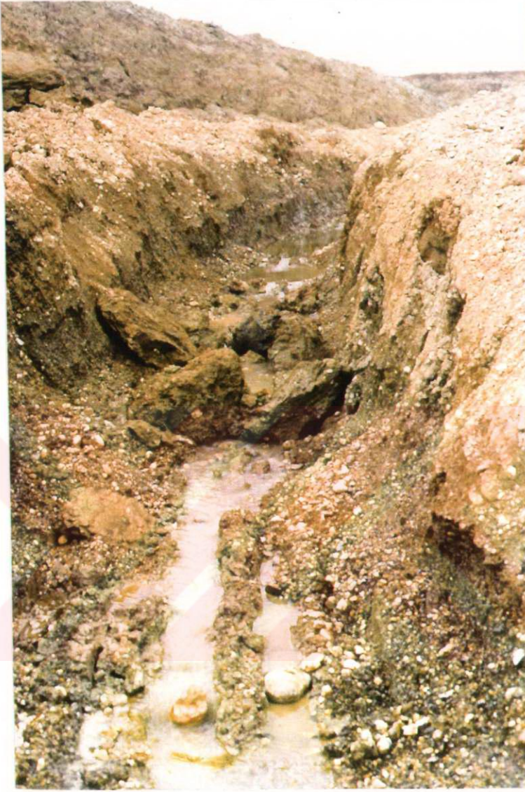
Şekil 4.7: İşletmenin güney şevinin üst basamaklarında yer alan alüvyondan sızan sular
