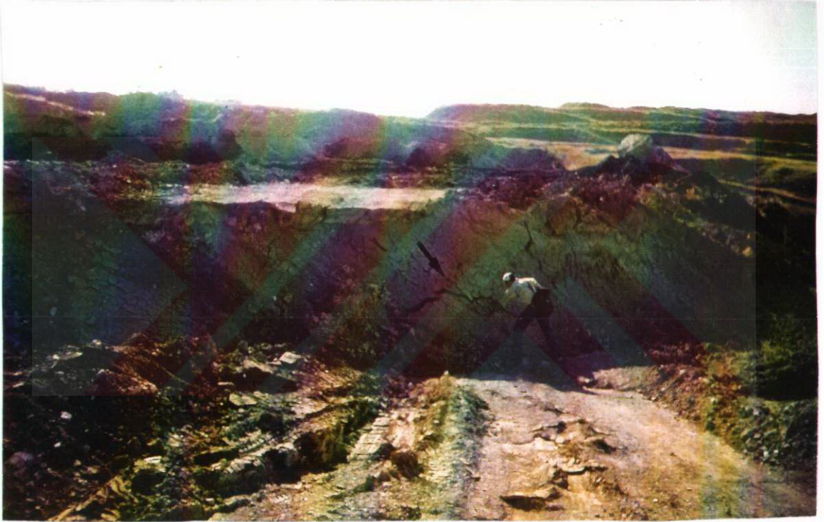
Şekil 5.11: Güney şevinin yaklaşık ortasında yeralan ve HEYELAN 3 olarak kodlanmış duraysızlıktan bir görünüm
