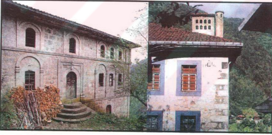
Şekil 7. Kâgir duvar örnekleri [7].
