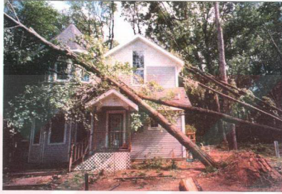
Şekil 24. Strüktürel Yalıtımlı Panellerle yapılmış bir konutun fırtınadan zarar görmemesi [16].
