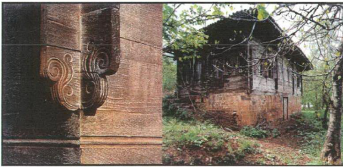
Şekil 4. Tahta yığma duvarlarla oluşturulmuş yapı örneği [7].
