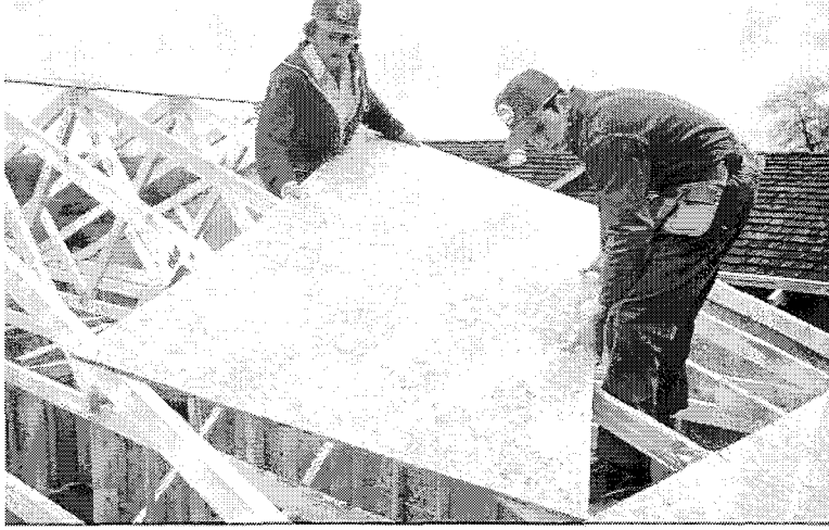
Şekil 36. Ahşap prefabrike makaslar üzerinde OSB çatı levhalarının yerleştirilmesi [19].
