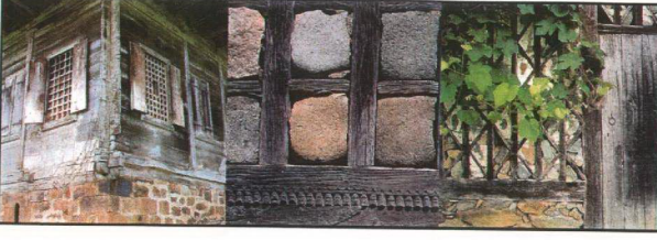
Şekil 6. Ahşap dolma, göz dolma ve muskalı dolma duvar örnekleri [7].
