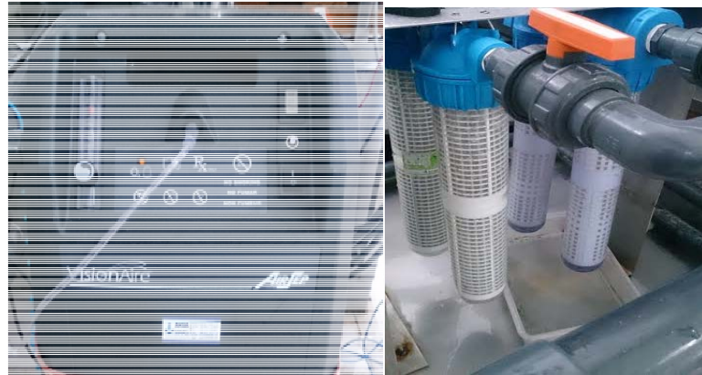
Şekil 3.2 Oksijen jeneratörü, biyolojik ve mekanik filtreler
