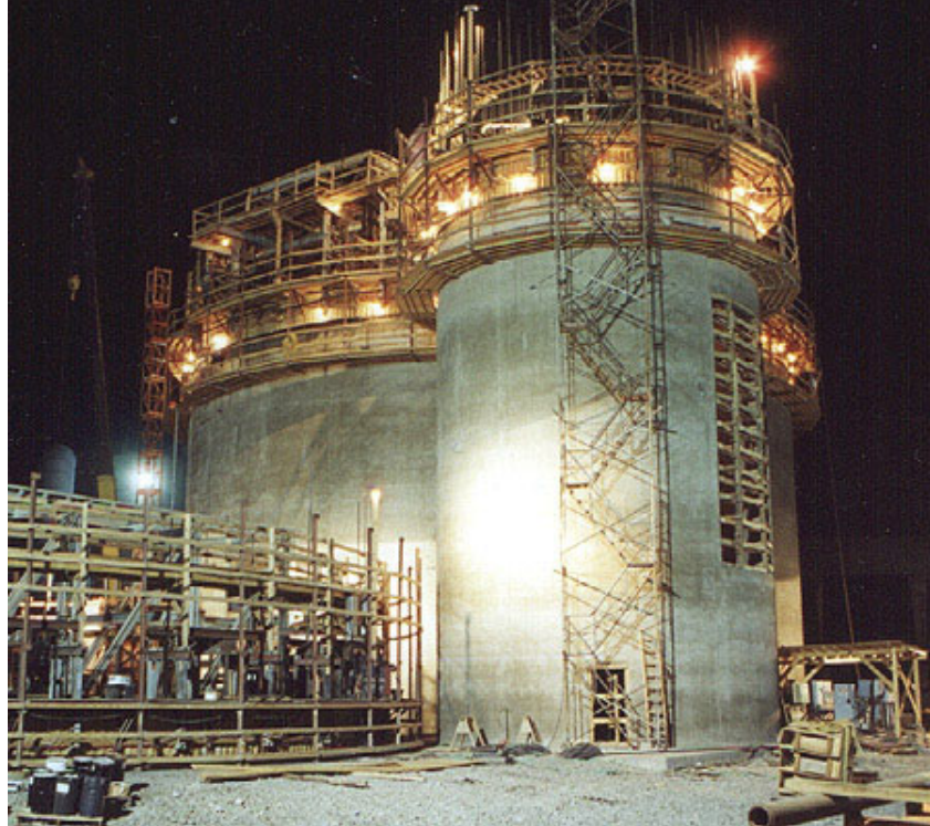
Şekil 1.26. Kayar kalıp tekniğiyle inşa edilen bir silo (URL-5, 2007).
