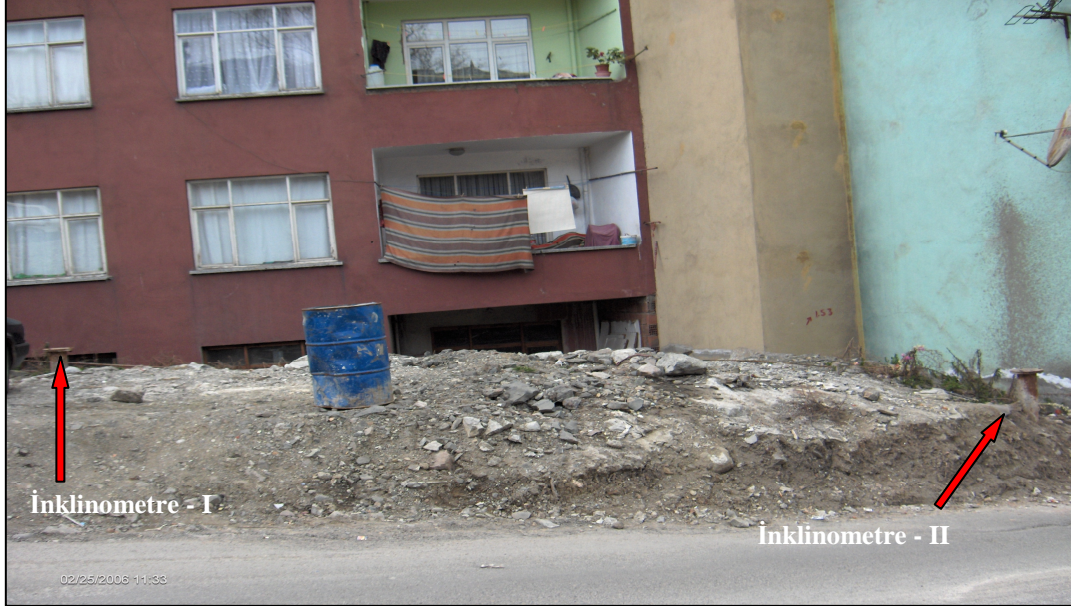
Şekil 2.6. Trabzon 2 Tünelinde tesis edilen inklinometre-I ve II boruları
