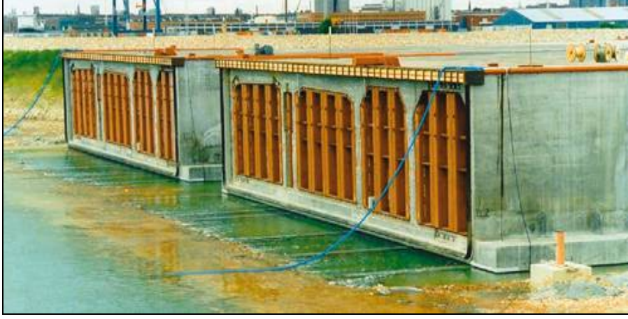
Şekil 1.4. Tüplerin yüzdürülmesi
