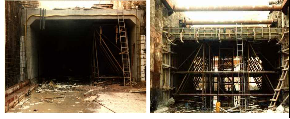
Şekil 1.1. Aç-Kapa yöntemi ile inşa edilen tünel
