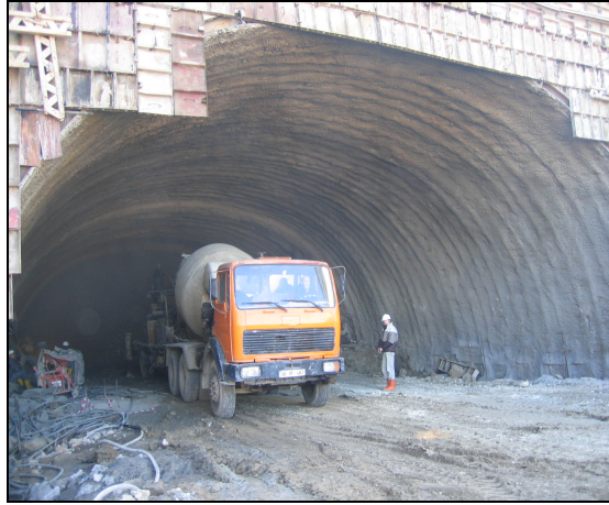
Şekil 2.5. Trabzon 2 Tüneli kazı çalışmaları
