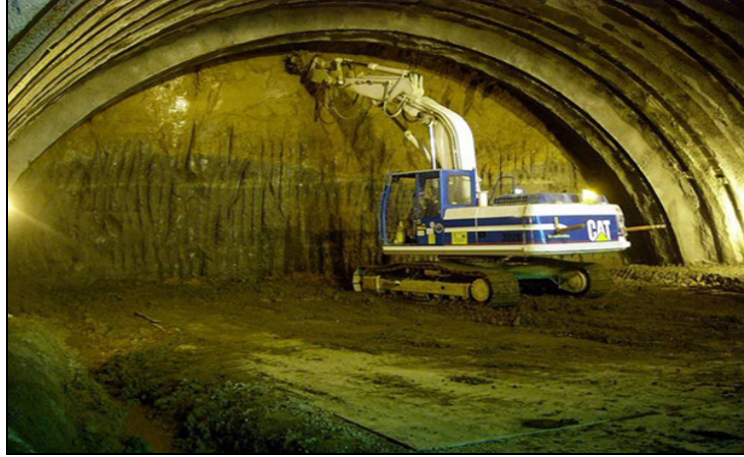
Şekil 1.6. NATM yöntemi ile tünel açma
