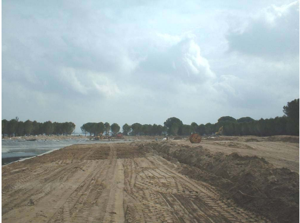
Şekil 4.51 Antreman sahası hazırlığı (Baysal 2001)
