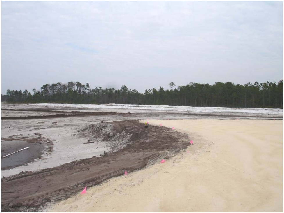
Şekil 4.19 Amick'in tasarladığı sahadan kum engeli altyapı inşaaı (Orijinal 2007)
