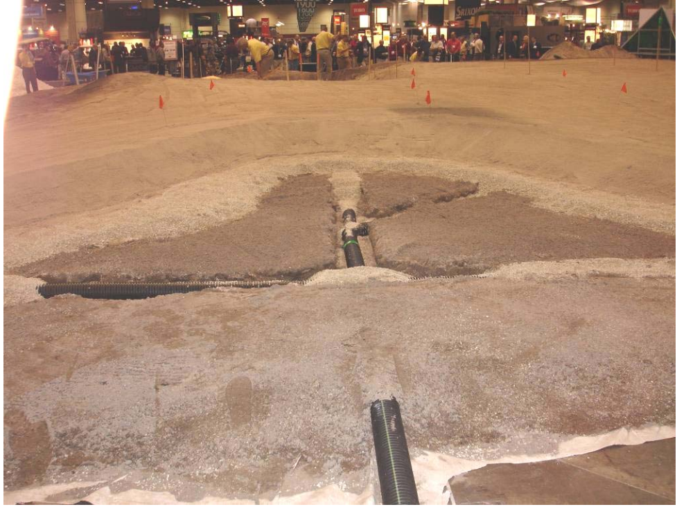
Şekil 4.25 Örnek greende ana drenaj hatlarının tesisi (Orijinal 2007)
