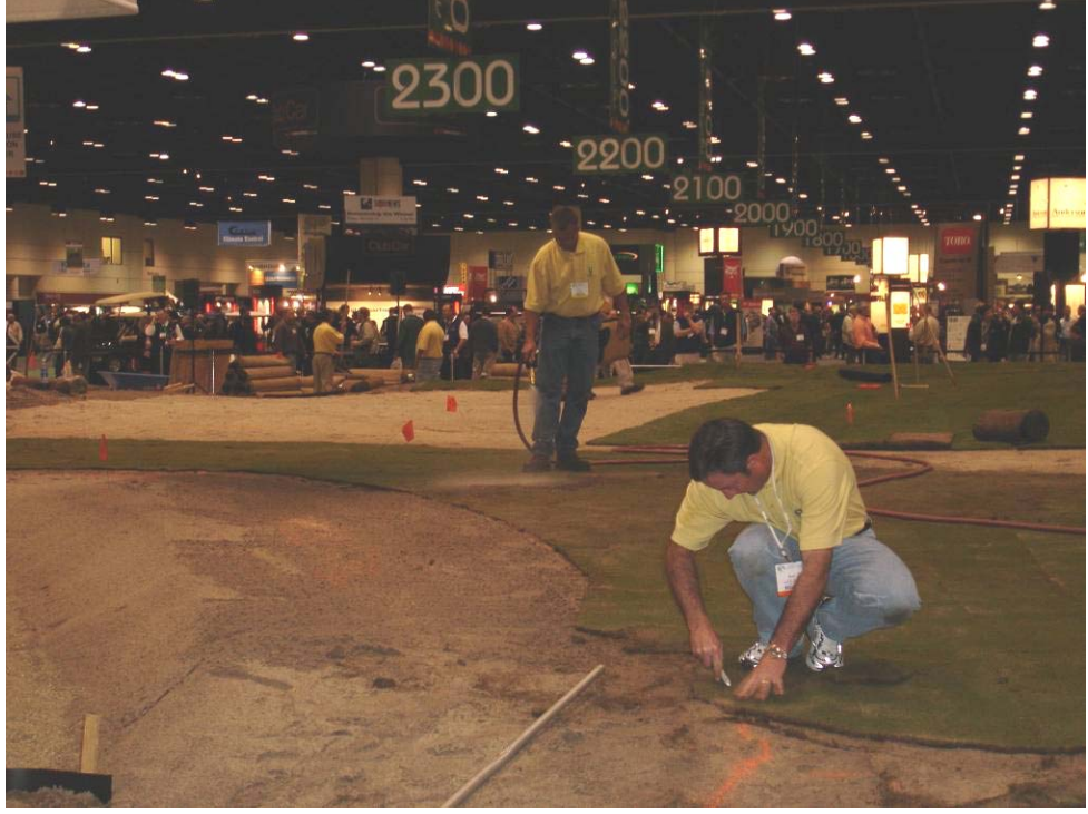
Şekil 4.29 Kalıp olarak yerleştirilen çimde son düzeltmelerin yapılması (Orijinal 2007)
