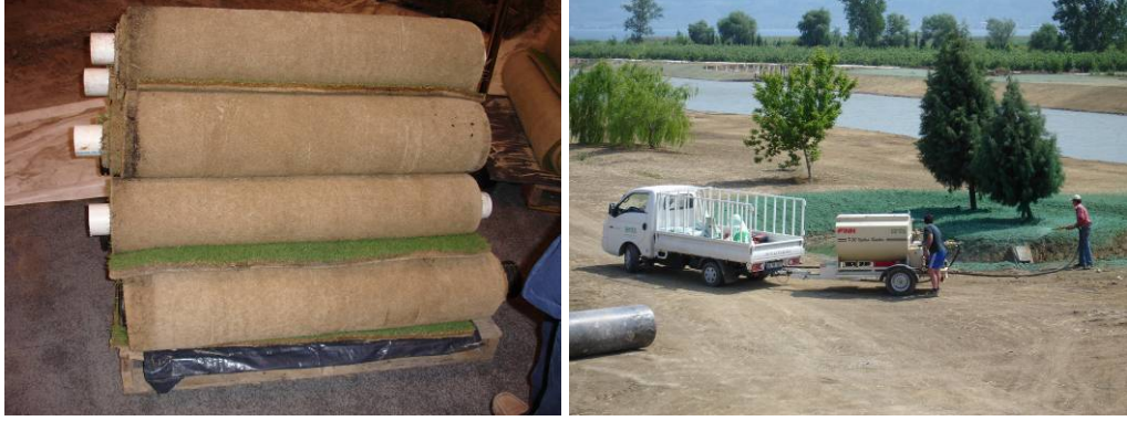
Şekil 2.30 Kalıp çim ve hidrolik tohumlama yöntemleriyle çim alan tesisi (Orijinal 2007)
