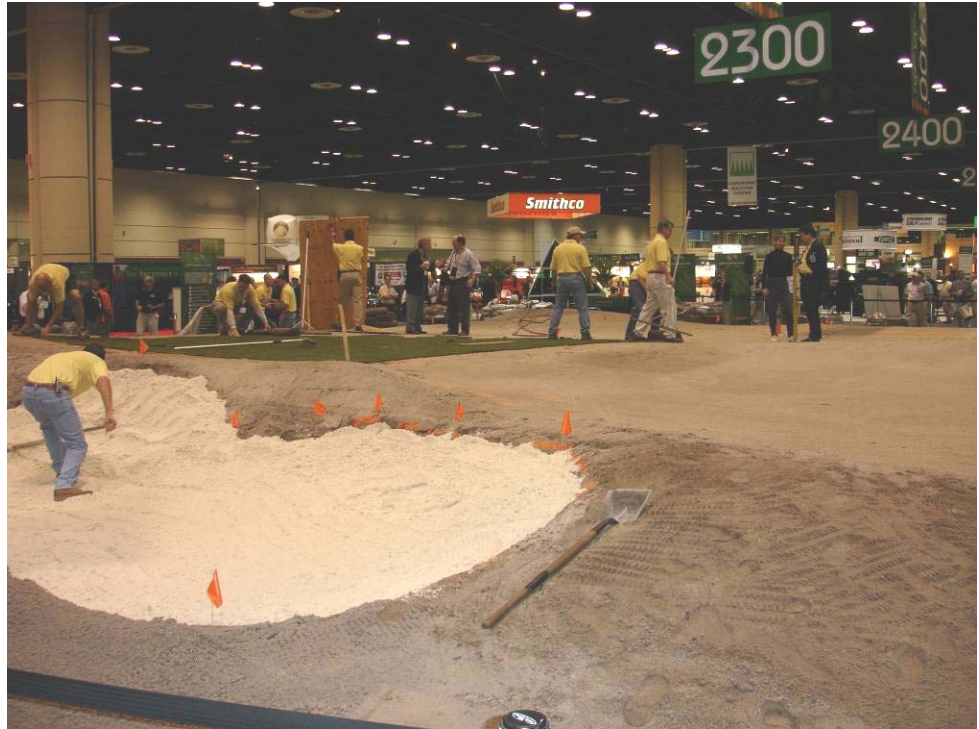
Şekil 4.27 Kum tuzağının malzemesinin serilmesi ve tesviyesi (Orijinal 2007)
