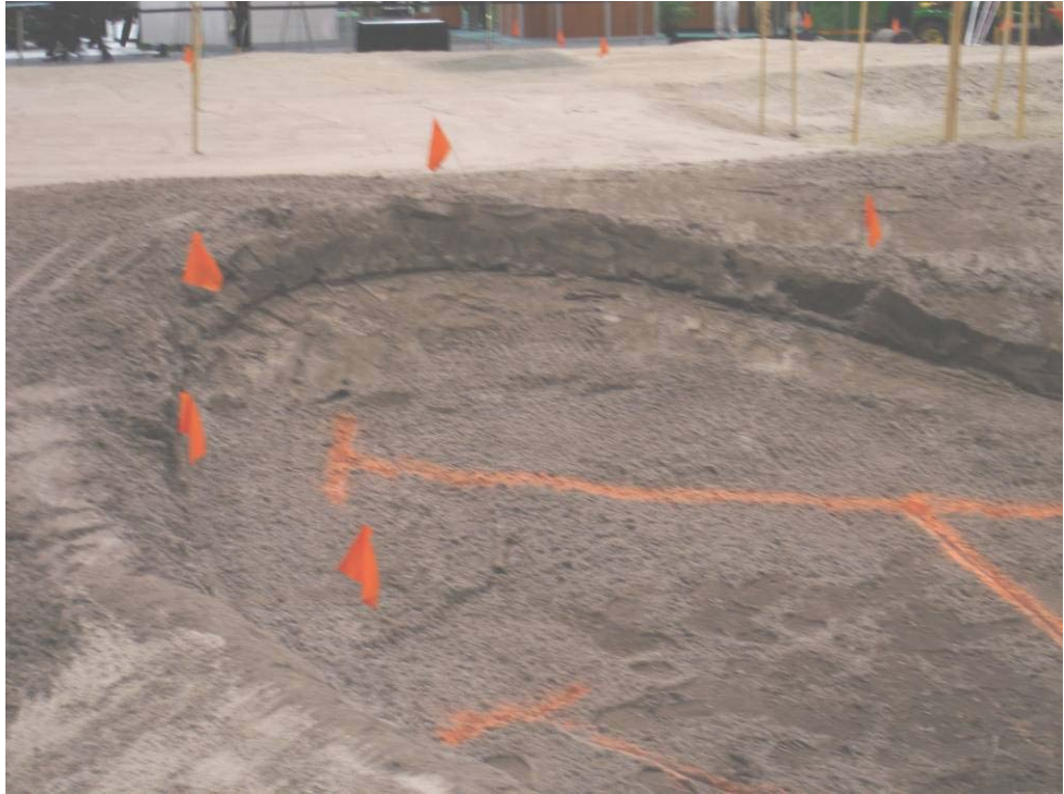
Şekil 4.24 Kum tuzaklarının drenaj hatlarının işaretlenmesi (Orijinal 2007)
