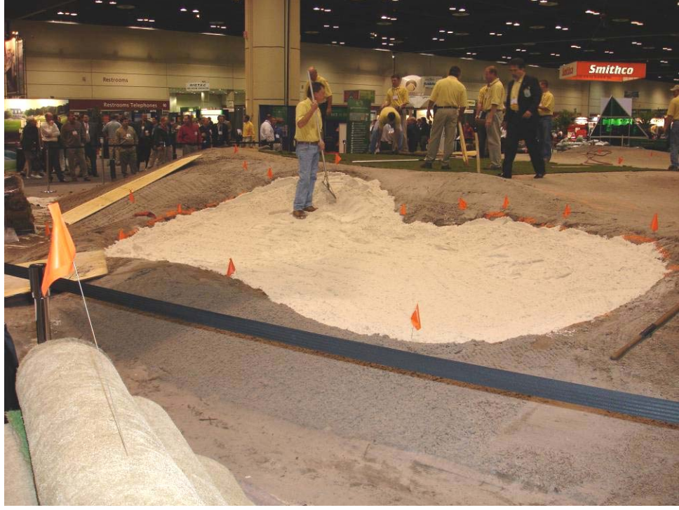
Şekil 4.27 Kum tuzağının malzemesinin serilmesi ve tesviyesi (devam) (Orijinal 2007)
