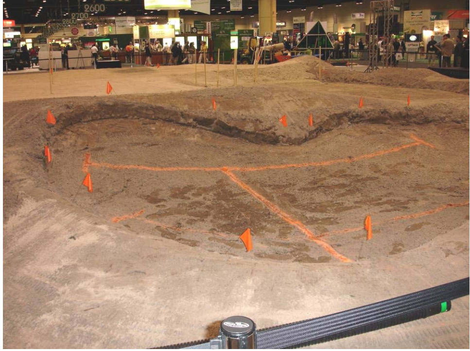
Şekil 4.23 Greende kum tuzaklarının drenaj hatlarının işaretlenmesi (Orijinal 2007)
