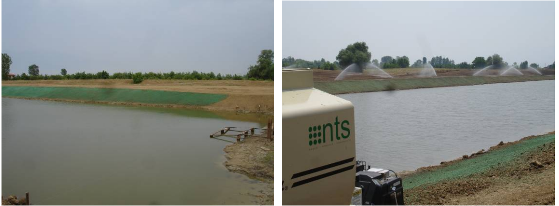
Şekil 2.31 Şev alanların hidrolik malçlama ile stabilize edilmesi (Orijinal 2007)
