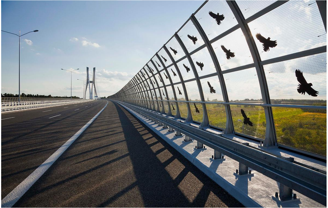
Şekil 1.11. Yol kenarı ses perdeleri (ses bariyeri)
