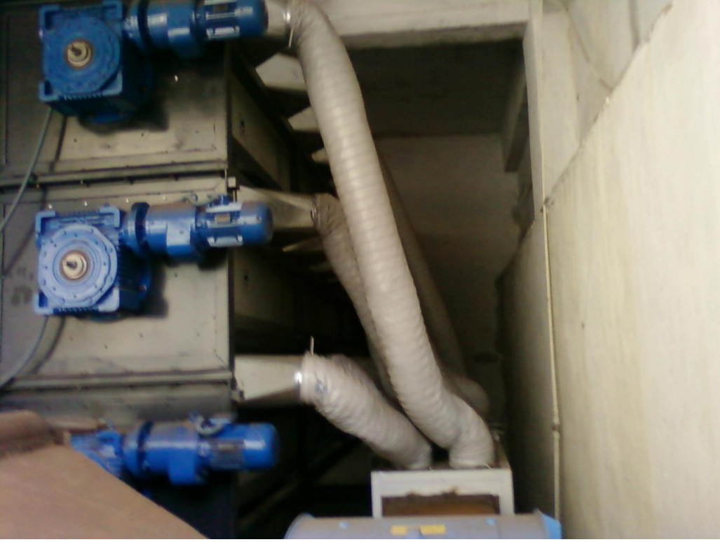
Şekil 27. Esnek boruların davlumbazlara bağlantı şekli
