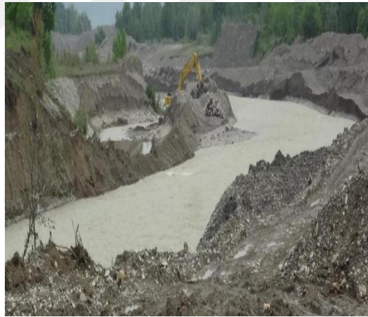
Şekil 16. Patlayan/Yıkılan Setlerin, Kuyruk Suyu Kısımına Giriş Yapması
