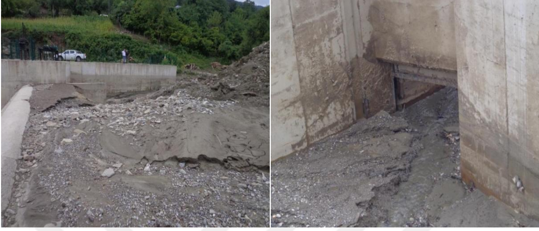
Şekil 14. Regülatörün Sel Suyunun Sürüklediği Teressübat Dolmuş Hali
