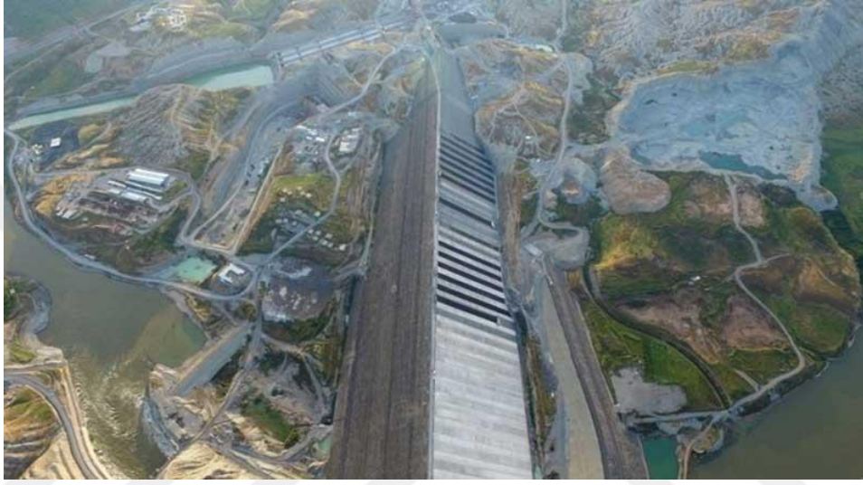
Şekil 2. Yarı Gömülü Santral Uygulaması (Ilisu Barajı ve Hidroelektrik Santrali Projesi)
