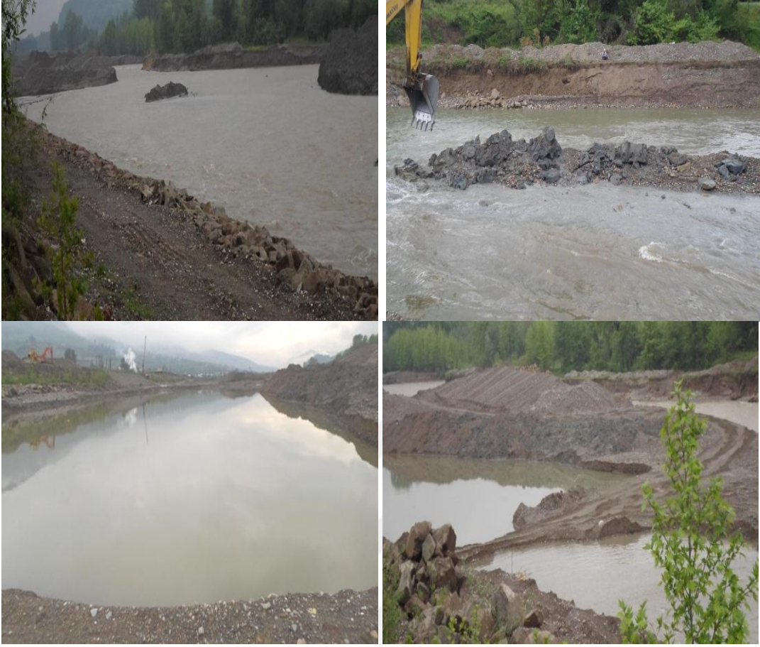
Şekil 17. Regülatör/Santral Binası Kazı Alanı
