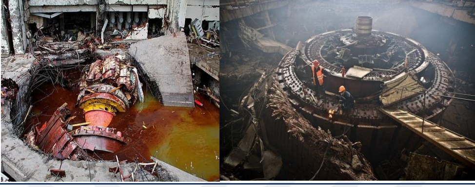
Şekil 11. Sayano-Şusenskaya Hidroelektrik Santralinde Transformatör Patlaması İle Meydana Gelen Hasar
