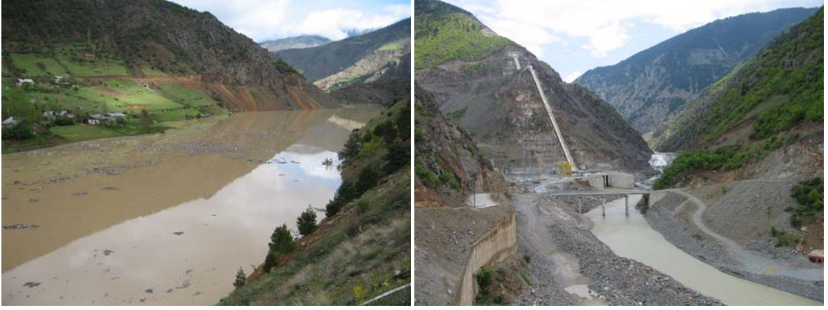
Şekil 12. Torul Baraj gölü ve hidroelektrik santrali (Bayram vd., 2010b)
