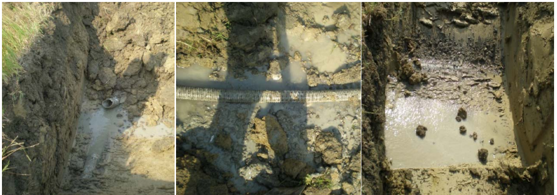
Şekil 3.11 Drenaj boruları ve zarf malzemelerinden bir görünüm
