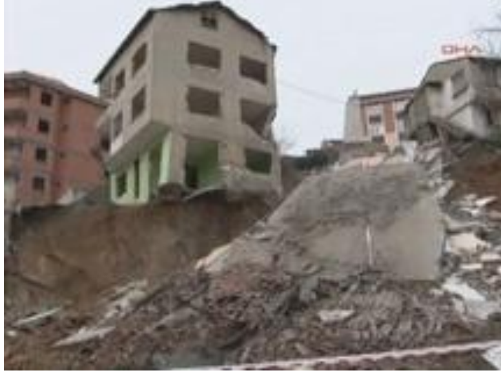
Şekil 3.3. İstanbul Gaziosmanpaşa'da yaşanan göçük olayı.
