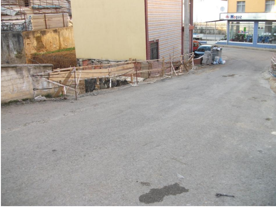
Şekil 2.36. Temeline teğet kazı yapılmış bina
