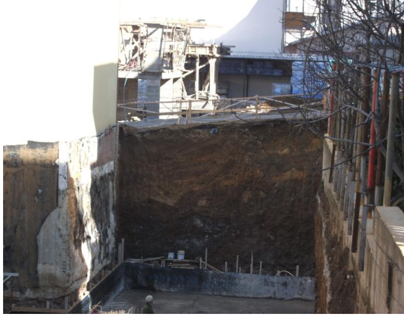
Şekil 2.26. Pelitli mevkiindeki temel çukuru
