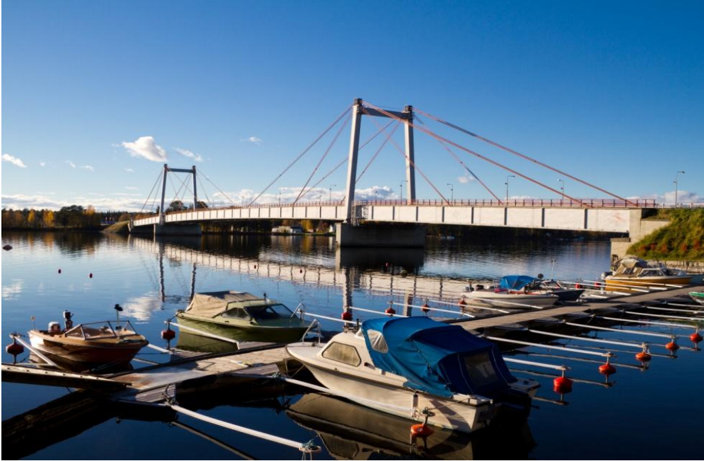
Şekil 1.6. Strömsund Köprüsü ( URL-6, 2012)
