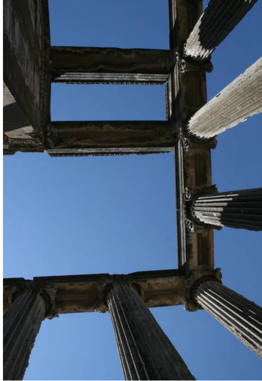
Şekil 4.14 Arşitrav ve sütun birleşimleri
