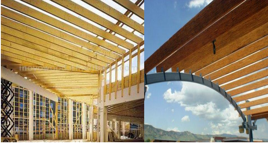
Şekil 5. LVL uygulama örnekleri
