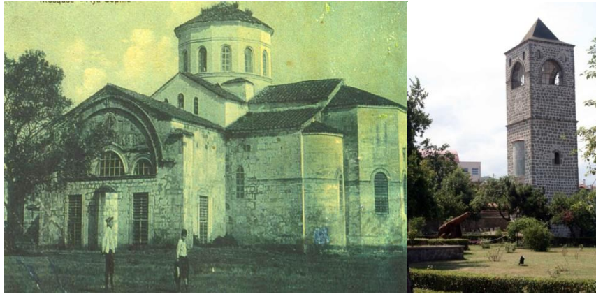
Şekil 21. Ayasofya Kilisesi ve Çan Kulesi (URL-7, URL-8)
