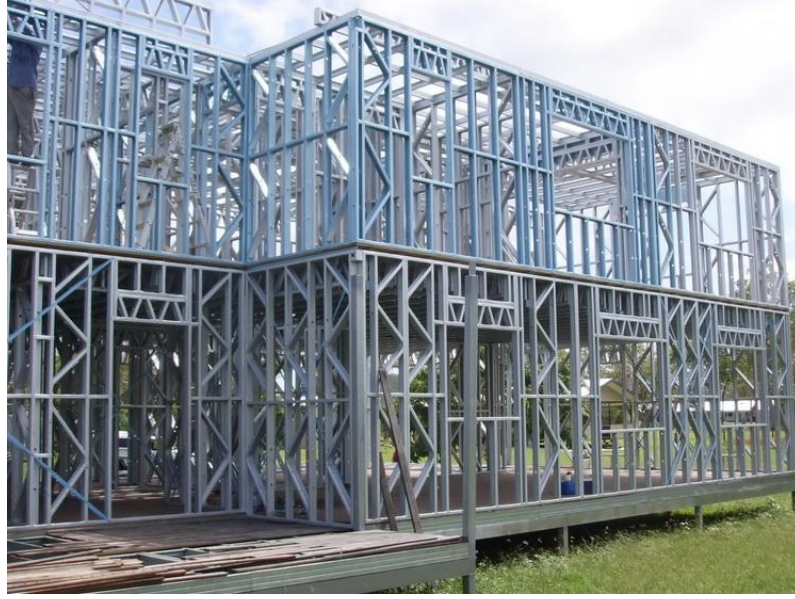
Şekil 24.Hafif profil duvar elemanları
