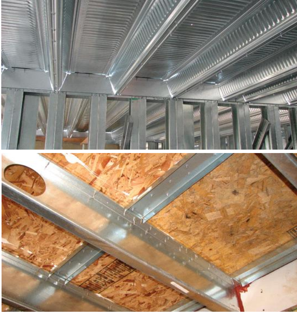
Şekil 27. Hafif profil döşeme sistemleri [9].
