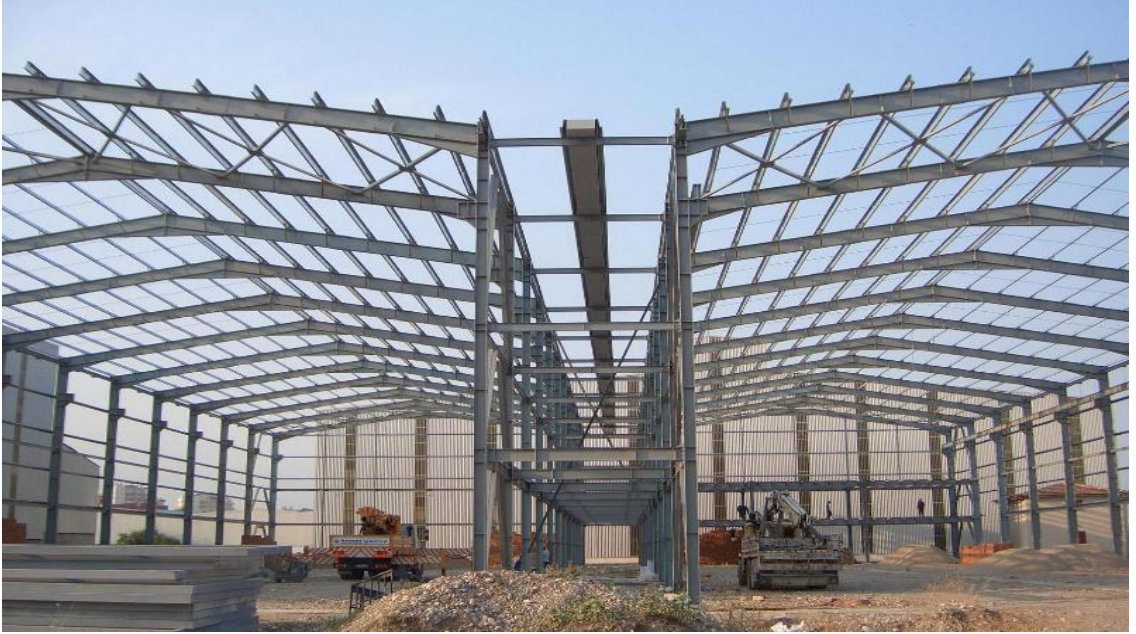
Şekil 28. Hafif profillerin endüstriyel yapılarda kullanımı
