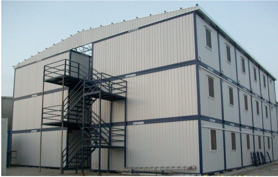
Şekil 30. Hafif profillerin geçici yapılarda kullanımı
