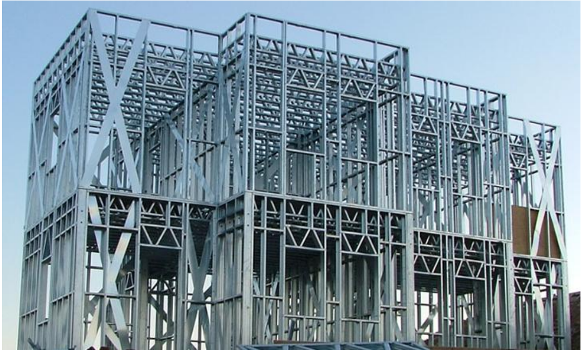
Şekil 25. Hafif profillerle inşa edilmiş konut türü bir yapı tipi [8].
