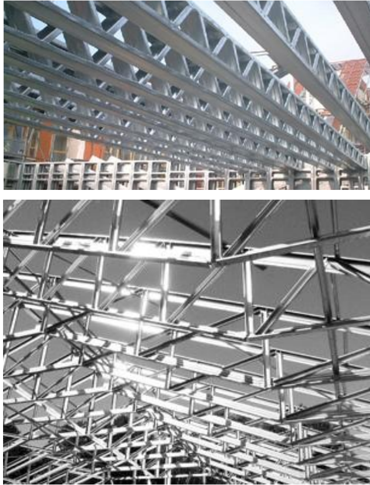
Şekil 22. Hafif profil kafes kirişler
