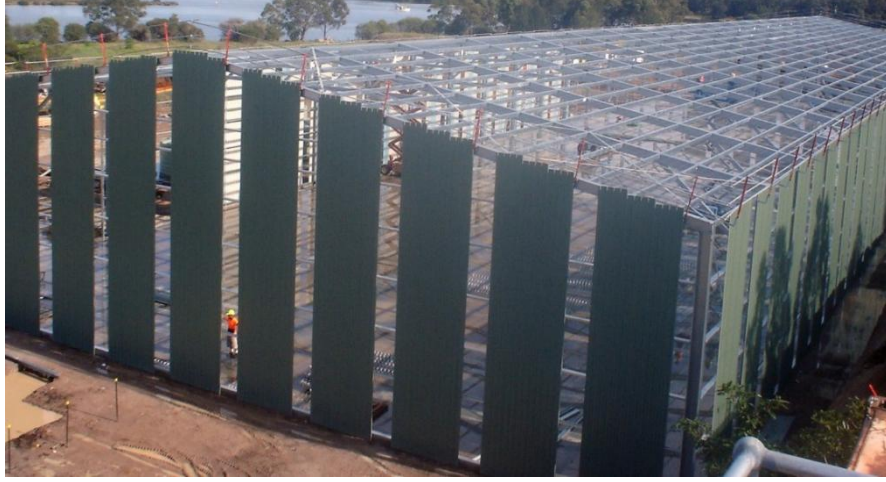
Şekil 29. Hafif profillerin endüstriyel yapılarda kullanımı
