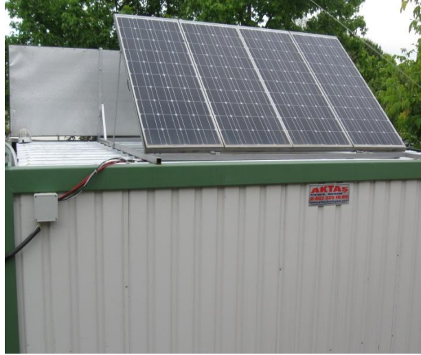
Şekil 105. Güneş panellerinin montajının görüntüsü
