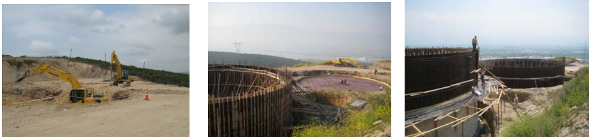
Şekil 3.3. Tesis temel kazı ve inşaat çalışmaları (Tübitak MAM Teknik Rapor-5, 2008).
