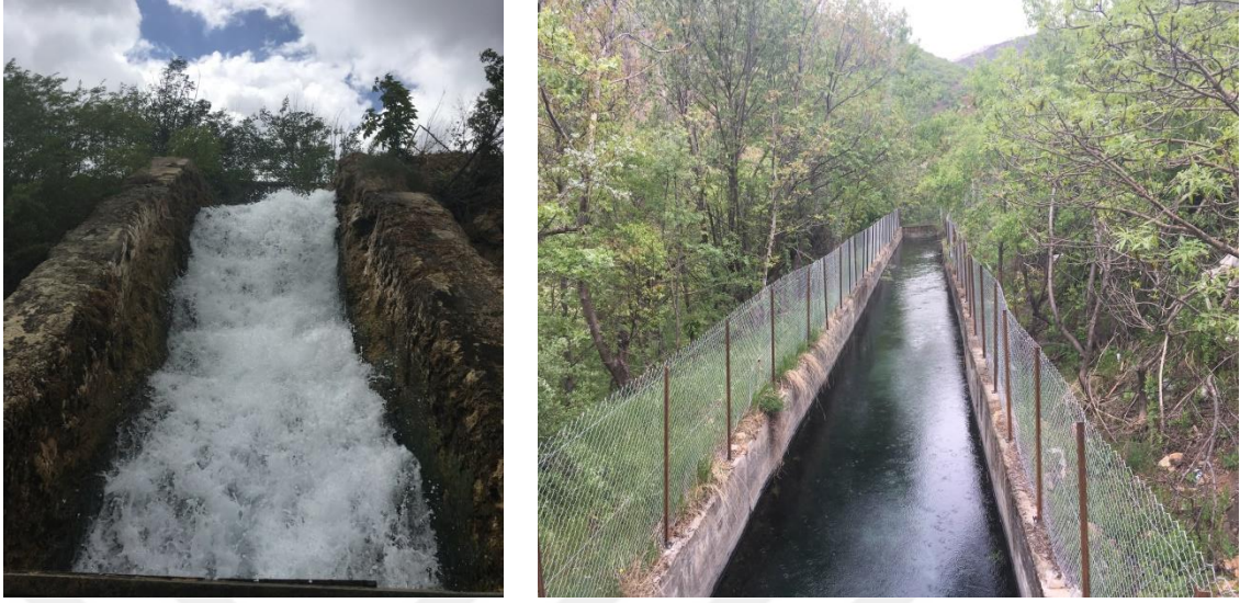
Şekil 4.25. Erzincan Girlevik Hidroelektrik santralinden görüntüler (Nisan 2018)
