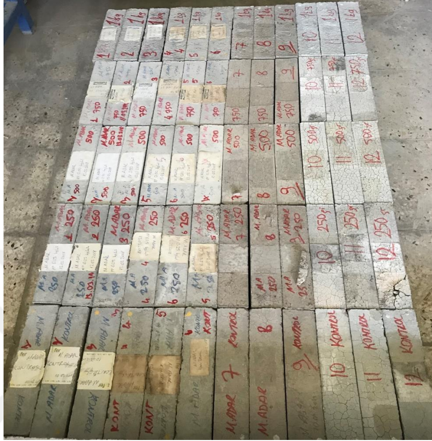
Şekil 4.14. Numuneler üzerinde gözlemlenen kılcal çatlaklar
