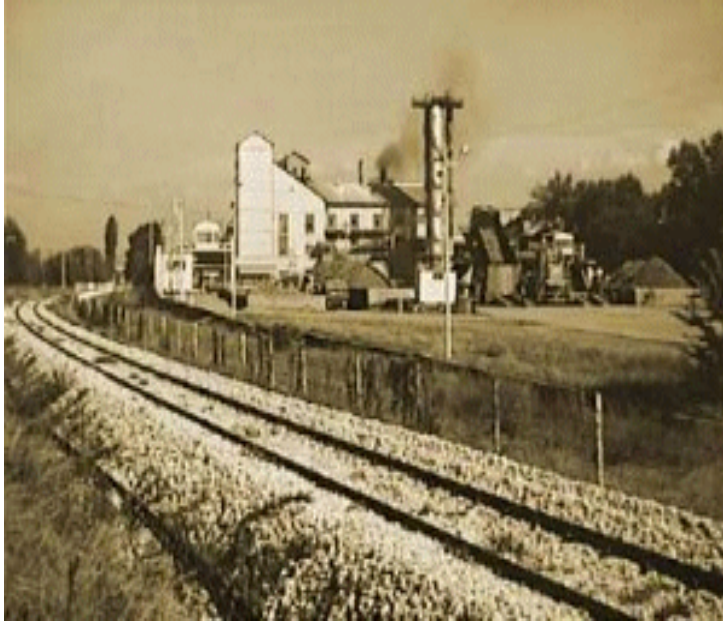
Şekil 2.2.Uşak Şeker Fabrikası
