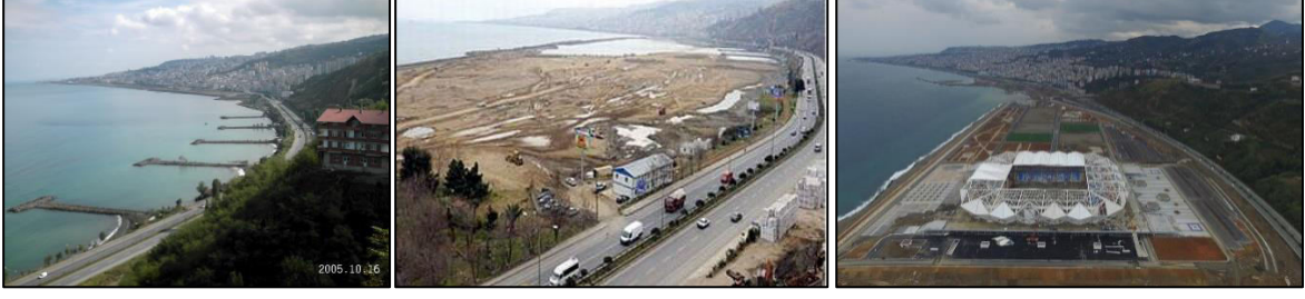
Şekil 8. Trabzon Akyazı bölgelerine ait dolgu yapılmadan önceki ve sonraki durumu gösteren fotoğraflar (URL-4, URL-5, URL-6)
