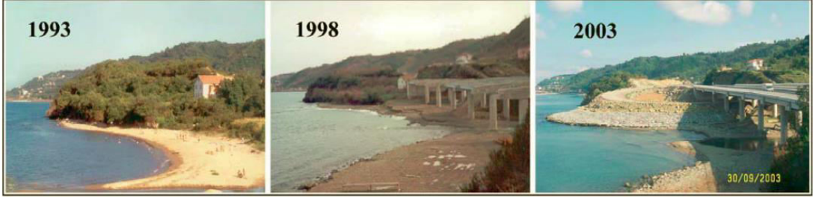
Şekil 11. Yanbolu köyüne ait karayolu inşaatından önceki ve sonraki durumu gösteren fotoğraflar (Sesli, 2006)
