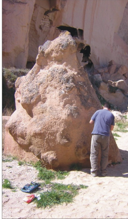
Şekil 5.15. Zelve 1. Vadi'nin tabanında aşınmanın etkisinin belirlenmesi amacıyla yerleştirilen çivilerin yerleri: (a) topuğu aşınan yamaç ve (b) vadi tabanında çivi yerleştirilen blok.
