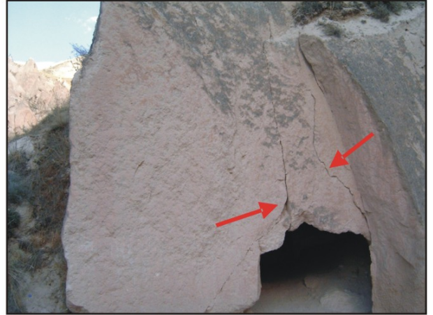
Şekil 5.5. Çeşitli nedenlerle oluşan ve ilerleyen çatlakların mevcut süreksizliklerle veya açıklıkların kapı, pencere gibi elemanlarıyla kesişerek duraysızlığa maruz kalabilecek yeni bloklar oluşturmasına ilişkin tipik görüntüler.
