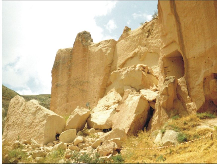
Şekil 1.3 Zelve 1. Vadi'nin giriş kesimindeki kayadan oyma Geyikli Kilise: (a) önceki yıllarda kilisenin tavanında meydana gelmiş göçme, (b) 2009 yılında gelişen toptan göçme.
