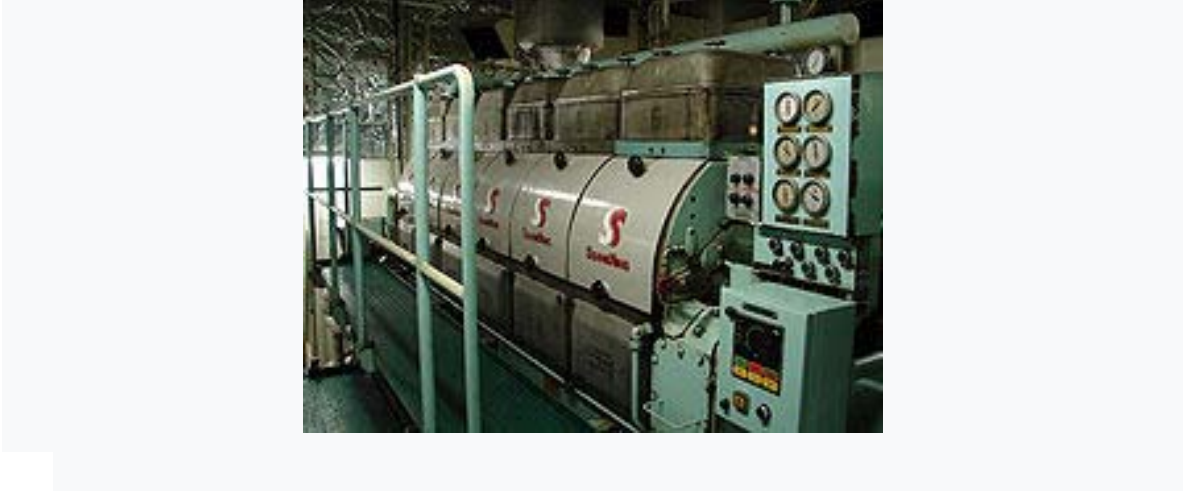
Şekil 1.9. Petrol tankerinin dizel jeneratörü
