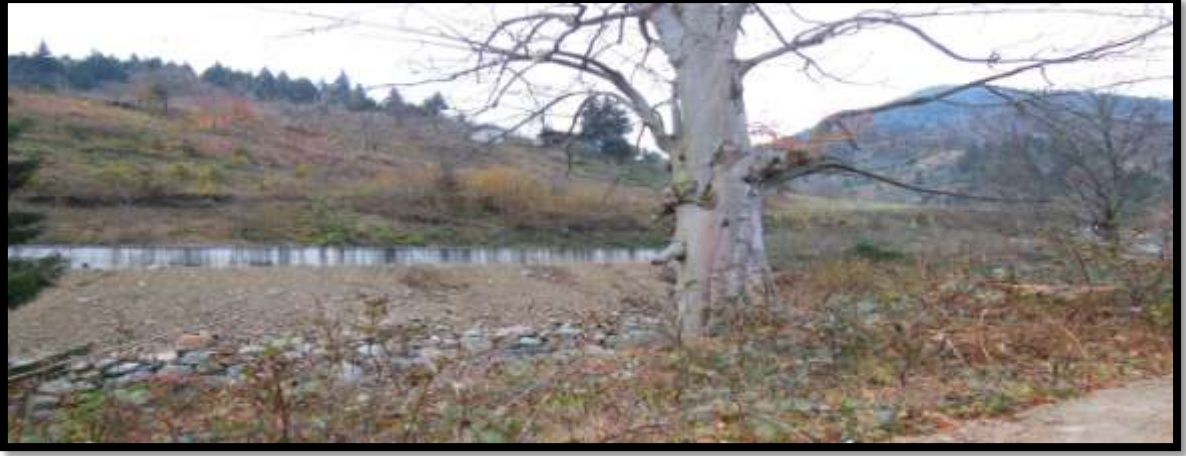
Şekil 12. Cansu HES iletim tüneli (17.11.2015)
