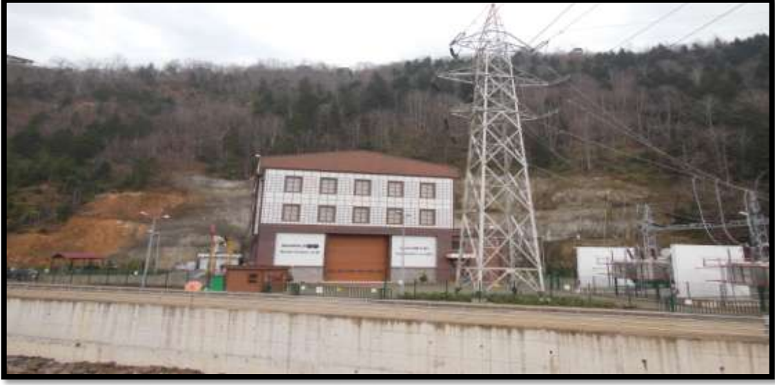
Şekil 27. Çambaşı santral binası (23.12.2015)
