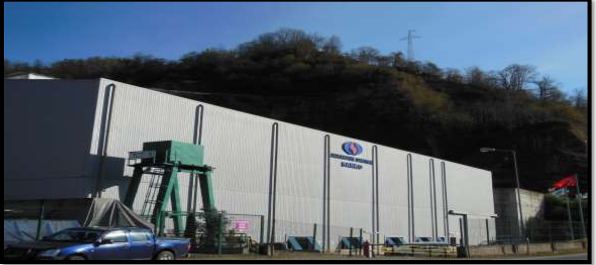
Şekil 21. Kalkandere santral binası (17.12.2015)
