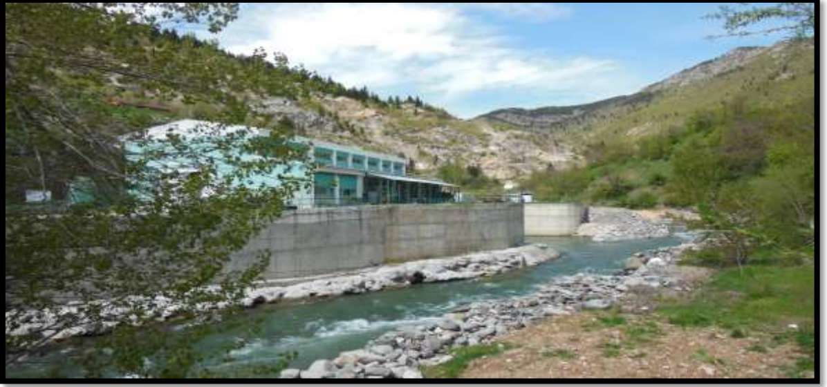
Şekil 13. Papart HES binası (24.04.2016)
