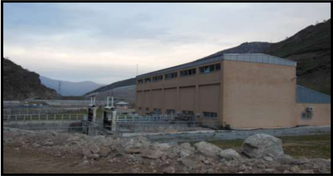
Şekil 8. Cansu santral binası (17.11.2015)
