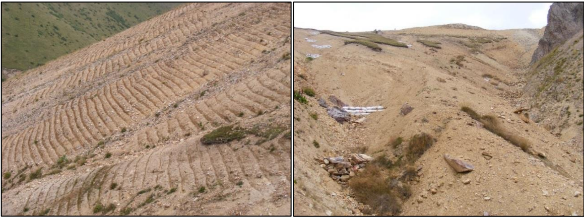
Şekil 4. Erozyon tehlikesine karşı yamaçta eşyükselti eğrilerine paralel olarak yapılmış arazi hazırlığı ve oyuntu erozyonu tehlikesine karşı yapılmış olan kuru duvar eşikler ve çuvallı setler (Trabzon, Tonya)
