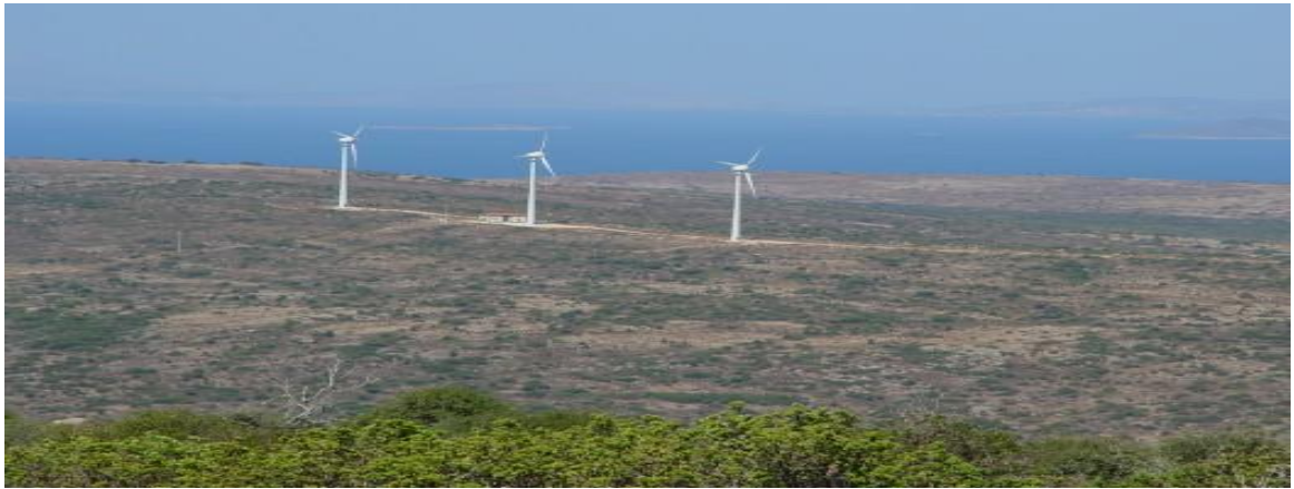
Şekil 10. Rüzgar enerjisi türbinleri
