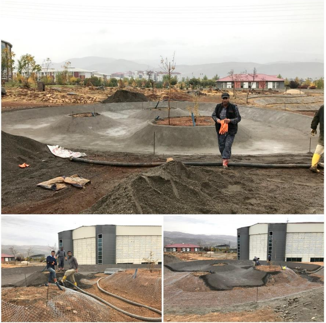
Şekil 4.14. Yüzen ada inşaatında yapısal işlemler (06.12.2017)
