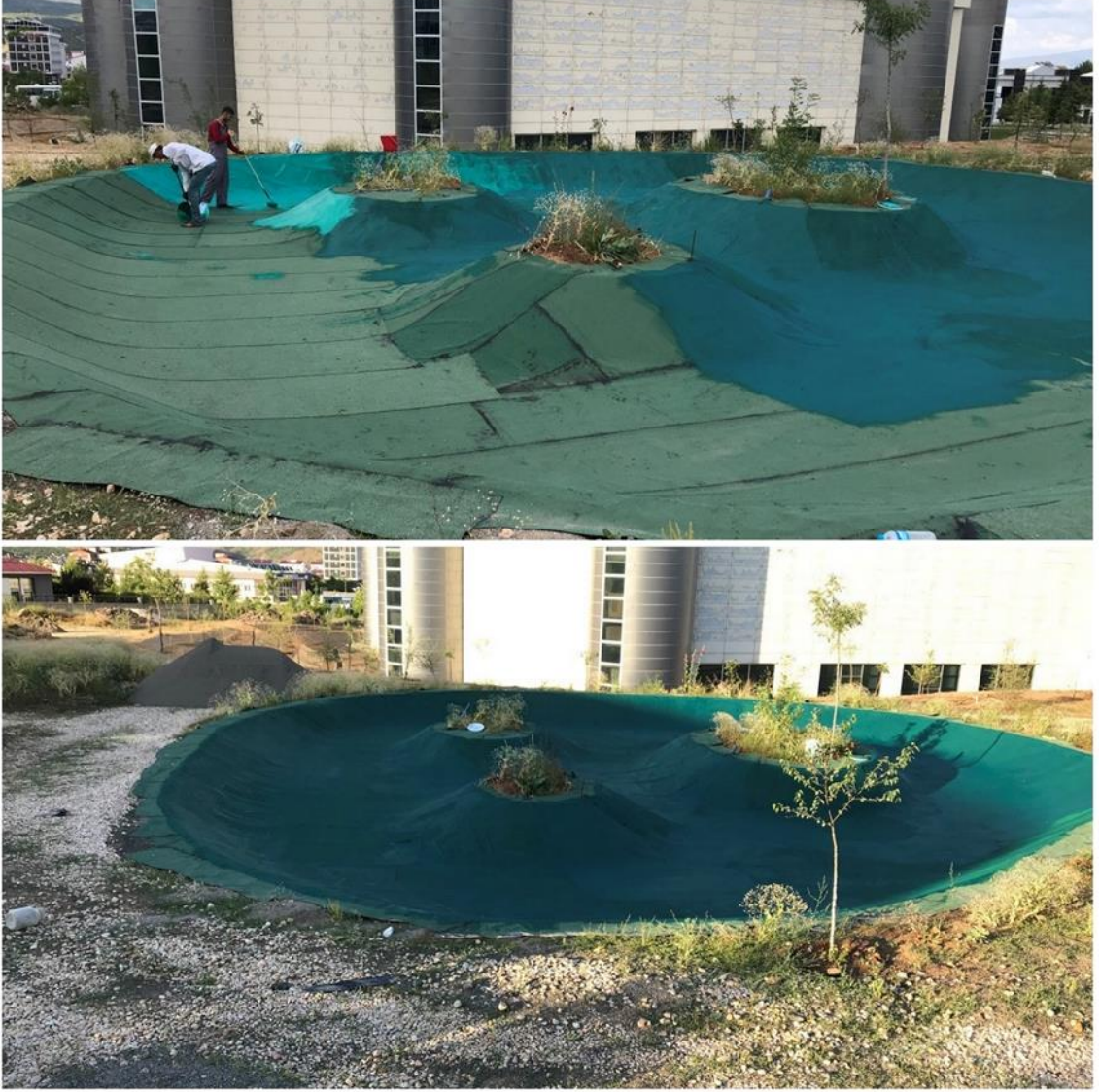
Şekil 4.15. Yüzen ada inşaatında yalıtım işlemleri
