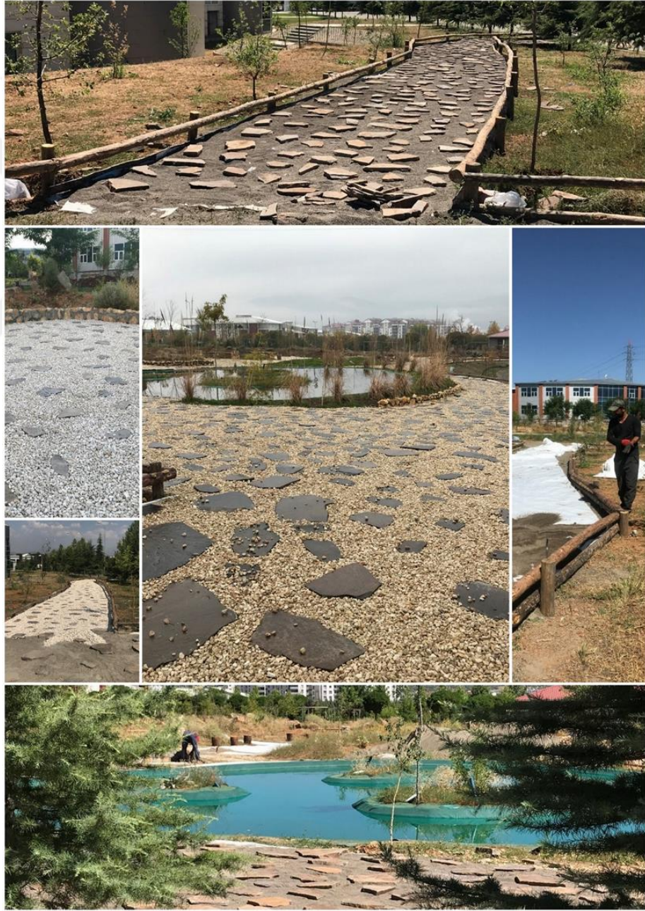
Şekil 4.19. Yürüme yolu yapım aşamaları
