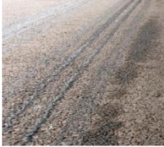
Şekil 7.Tekerlek izi oluşmuş yol kesimi [114]
