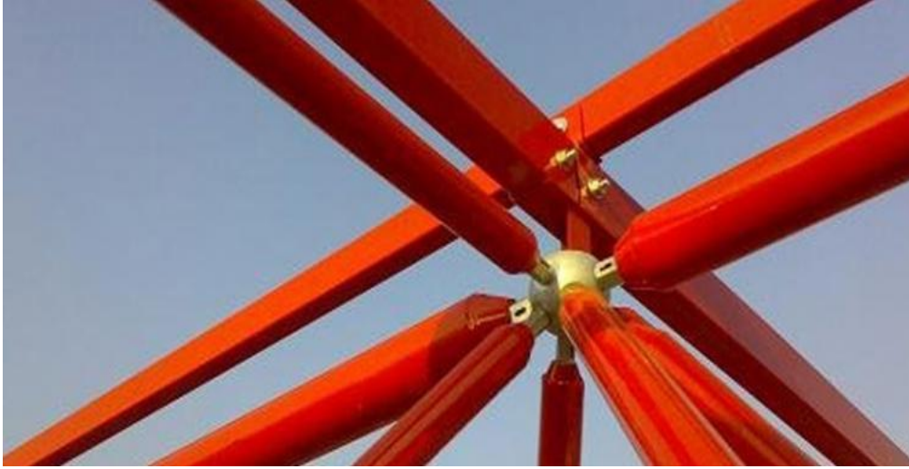
Şekil 1.10. Düğüm noktasında aşık ve aşık dikmesi detayları
