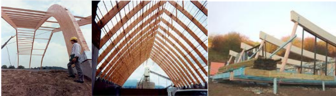
Şekil 5. Lamine kereste kirişlerin (Glulam) uygulama alanları
